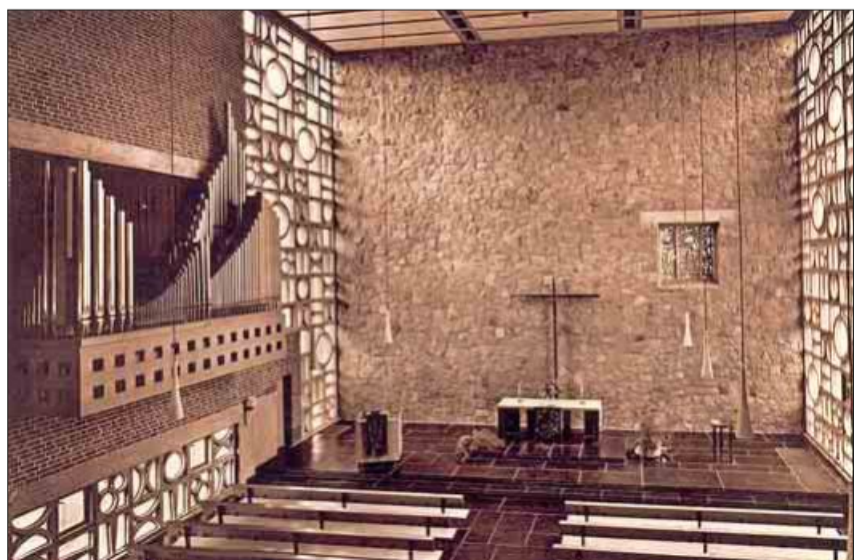
Das Innere der Kirche mit der Bruchsteinwand aus Granit auf einem historischen Foto
